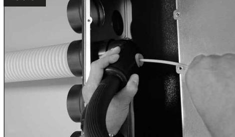
11. Bei starker Verschmutzung in der Lüftungsleitung, den Reinigungsvorgang wiederholen!
