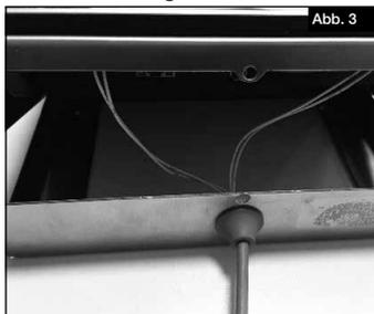
3. Bedienelement im Rahmen in die Wandhalterung einhängen und die Schraube (M3) durch die folgenden Bohrung schrauben, s. Abb. 4 Schraube M3 im Lieferumfang enthalten).
